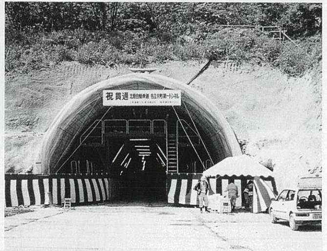
■トンネル貫通式
